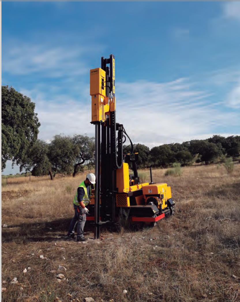
Máquina de hincado
