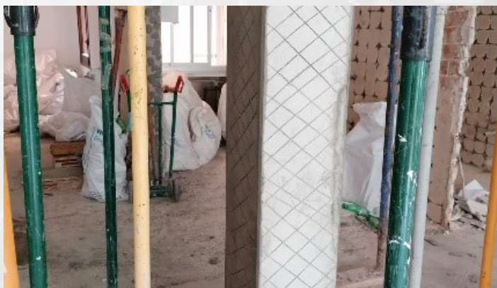
Restitución de la sección original del pilar
