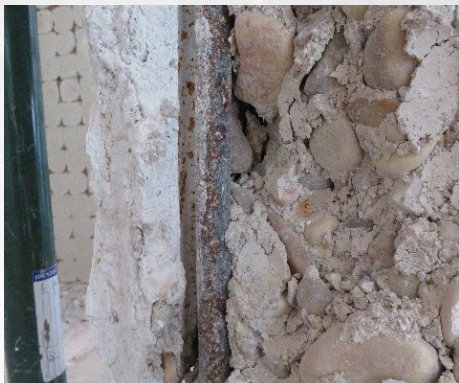
Eliminación del hormigón suelto
