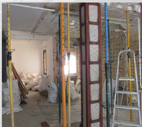
Empesillado de pilar
