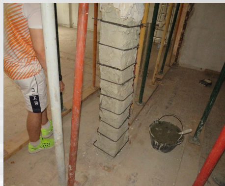
Colocación de estribos de refuerzo
