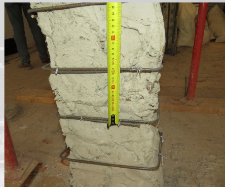
Colocación de estribos de refuerzo
