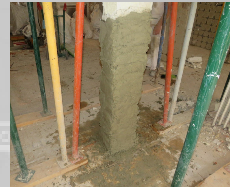
Aplicación de mortero estructural
