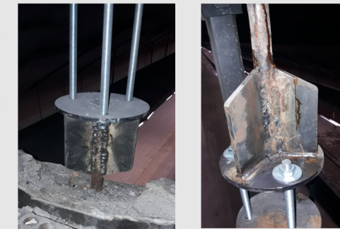
Tirantes de refuerzo tipo. Partes.
