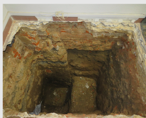
Toma de datos y apertura y reparación de calos y calicatas.
