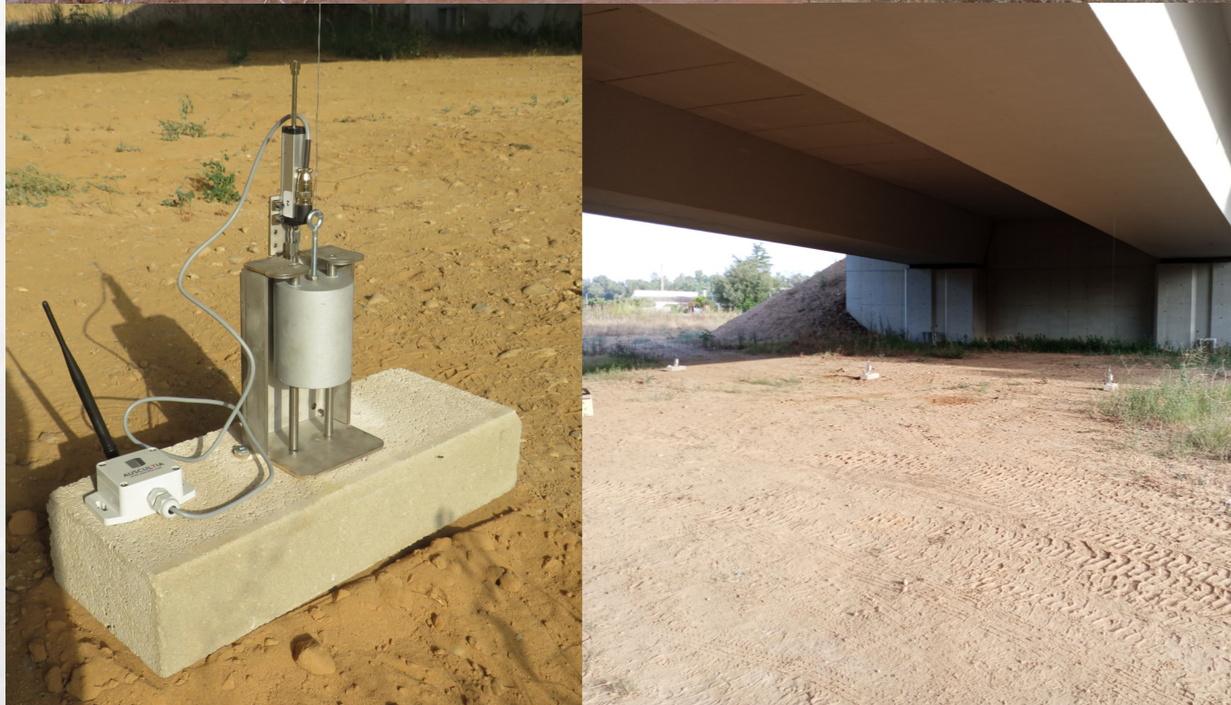
Sensores bajo vigas y centro y extremos de tablero
