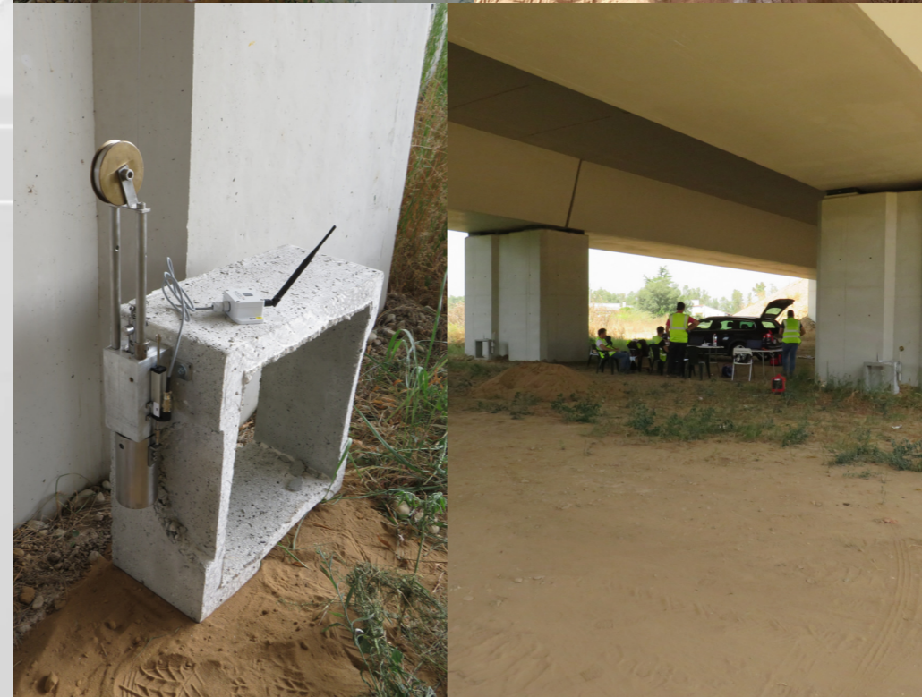
Sensores medidores de descenso en apoyos sobre pilas
