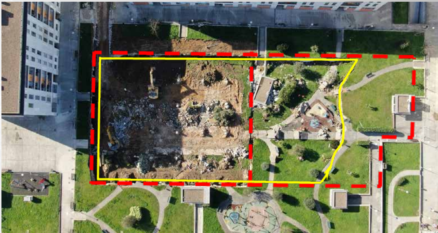
IMAGEN AÉREA ZONA DERRUMBADA. FUENTE: TOMA VUELO DRONE 29 ENERO DE 2020
