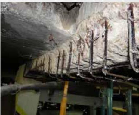
**Refuerzo a esfuerzo cortante ejecutado**
