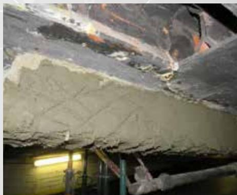
**Reparación con mortero estructural**
